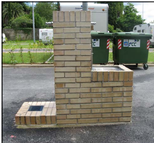
AREA DE SERVICIOS DE DONOSTIA (junio 2008) Borne artesanal, derecha zona sucia con la pileta para el vaciado y limpieza del depósito del váter. A la izquierda la fuente de agua limpia.
