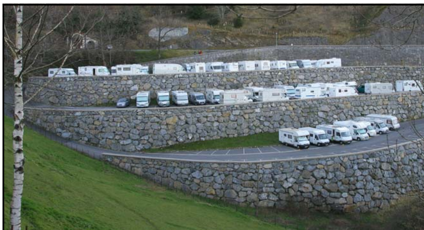
Parking N.S.de Aranzazu, Gipuzkoa (Foto Tuka)
