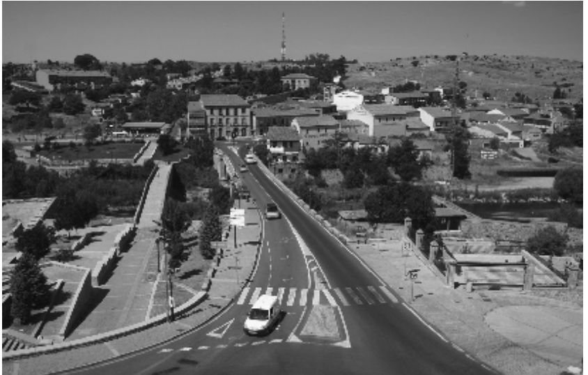
Puentes sobre el Adaja
