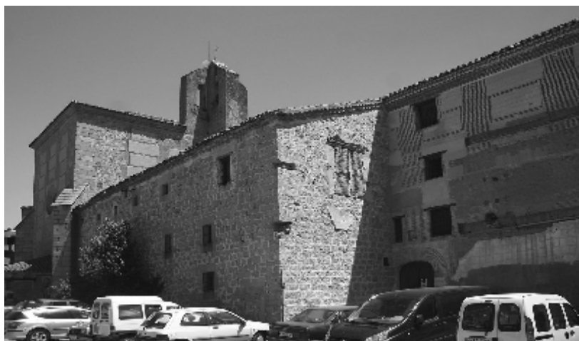
Cuerpo del edificio
