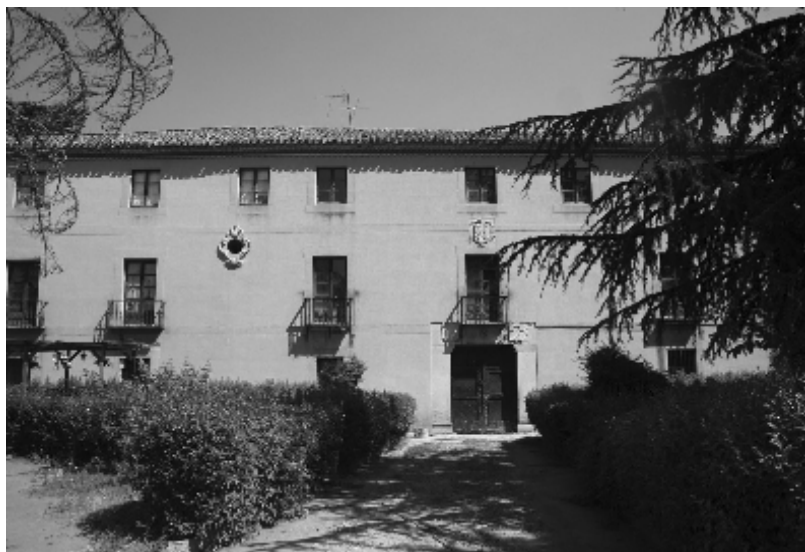
Palacio de Sofraga (fachada principal)
