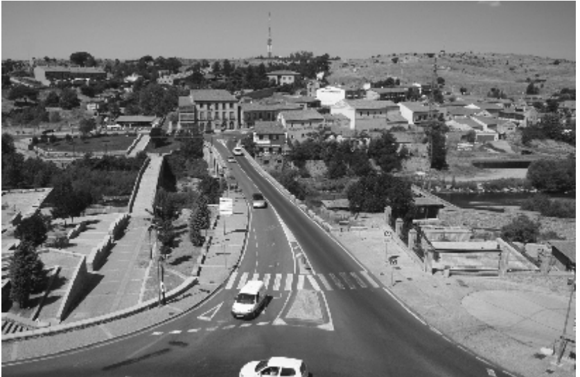
Plaza junto a la Puerta del Puente
