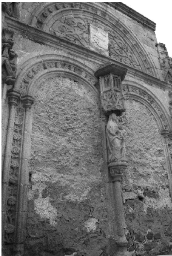
Portada del antiguo hospital de Santa Escolástica
