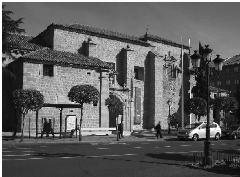
Fachada a la plaza
