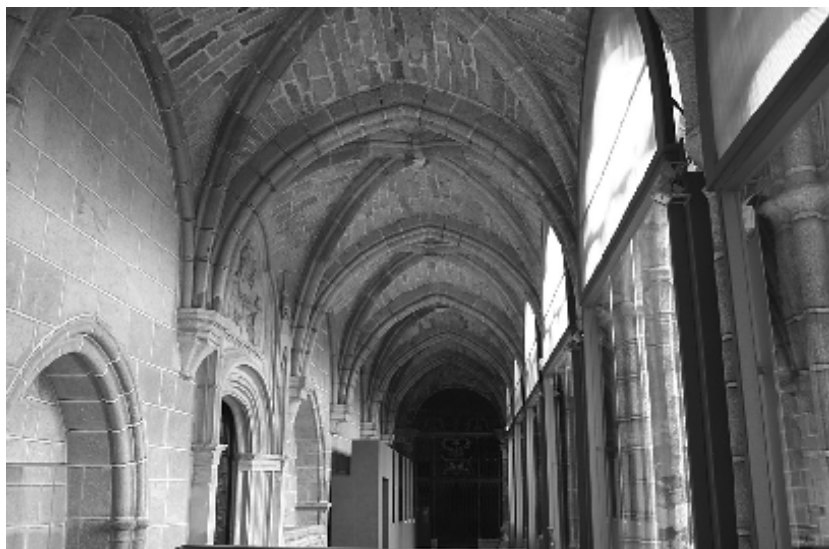
Galería del claustro
